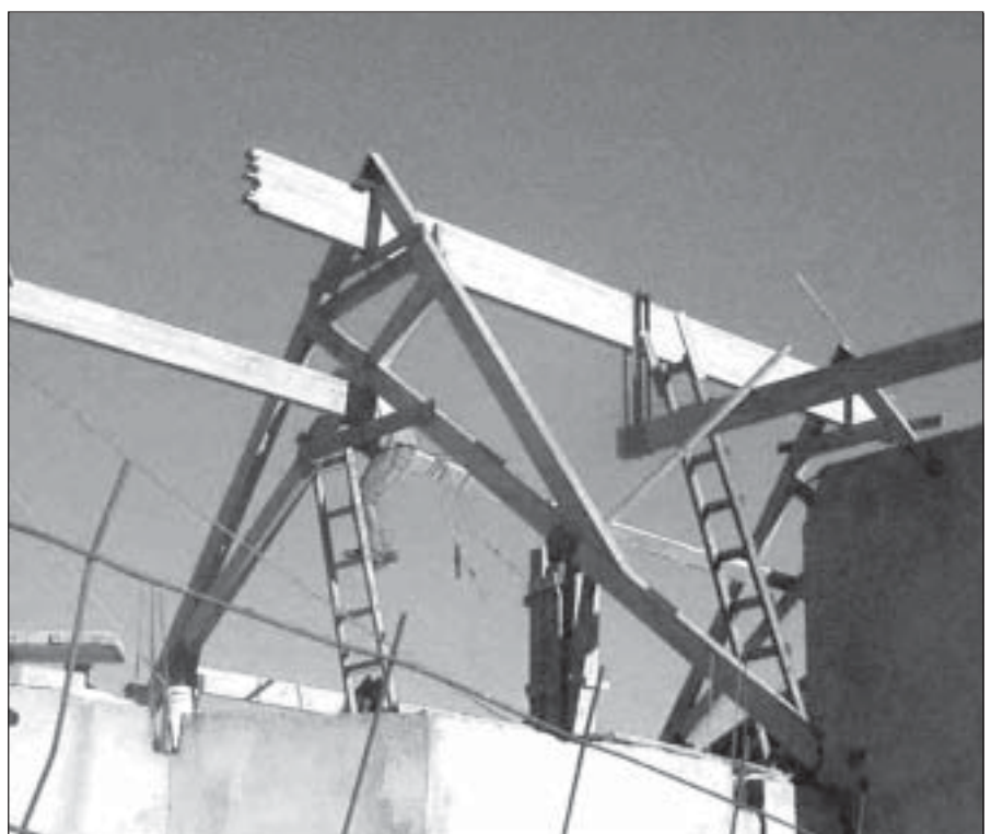
Foto 1. Madera estructural en construcciones.
