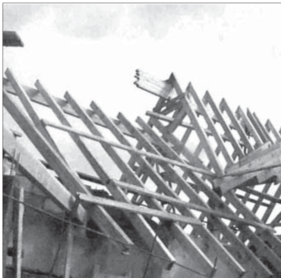
Foto 2. Estructura de techos con piezas de madera sólida y laminada.
