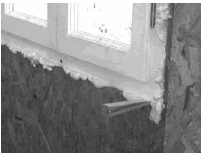
Figura 9: Colocación de aberturas con espuma de poliuretano
