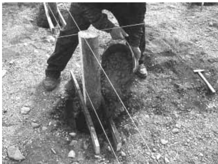
Figura 2: Colocación y empotramiento de pilotes.
