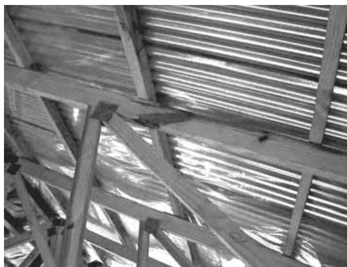
Figura 7: Cubierta de techo.
