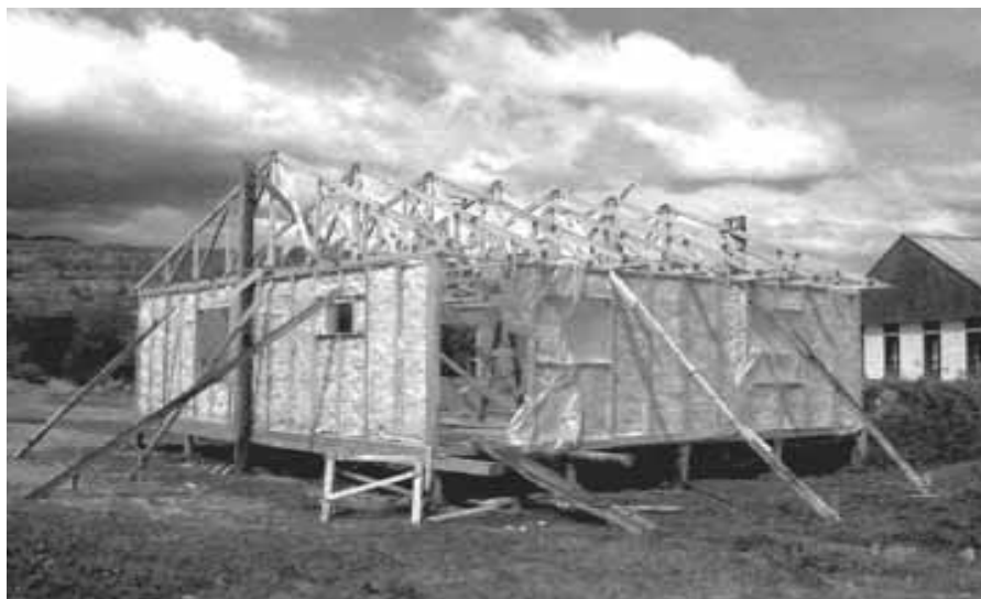
Figura 6: Cabriadas de techo.
