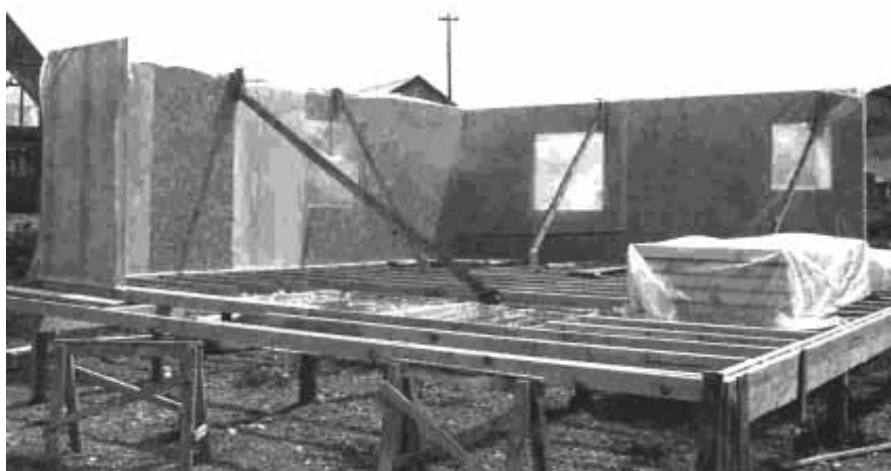
Figura 5: Instalación de los paneles
